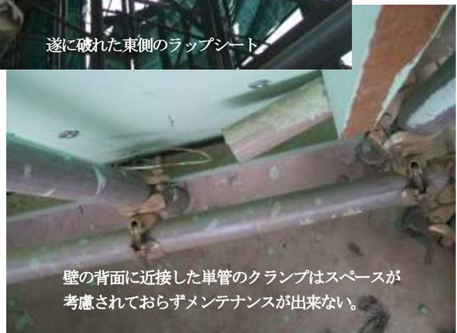
壁の背面に近接した単管のクランプはスペースが考慮されておらずメンテナンスが出来ない。
