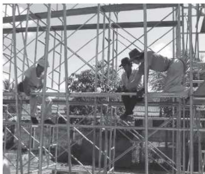
2010年1月21日、僕らの人工壁、アンコール・クライミング・ウォールの施工 2 日目。施工技術を学ぶC孤児院のソチエン(仮名、中央右寄り)。
